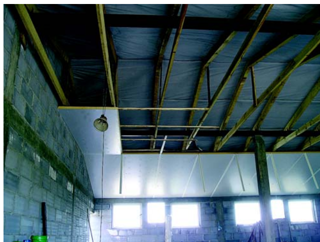
Wnętrze budynku w trakcie budowy - etap montażu systemowego sufitu termoizolacyjnego
