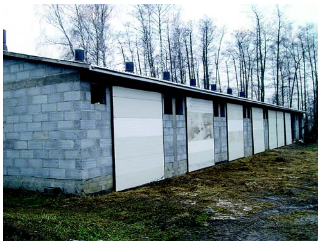
Widok na zrealizowany obiekt od strony ściany szczytowej
