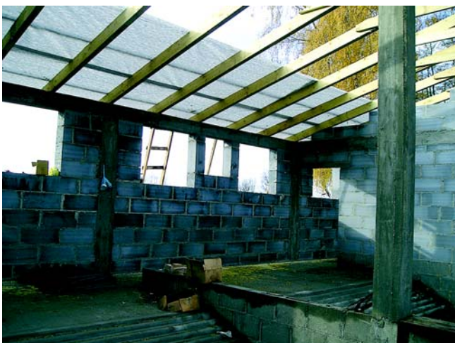
Wnętrze budynku w trakcie budowy - na pierwszym planie widoczne rdzenie żelbetowe (wyprowadzone z niskich ścian poprzecznych) podpierające konstrukcję przekrycia obiektu od strony ściany podłużnej. Widoczne otwory z wlotami powietrza
