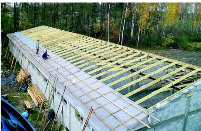
Budynek w trakcie budowy - jak na dłoni widoczna konstrukcja przekrycia obiektu
