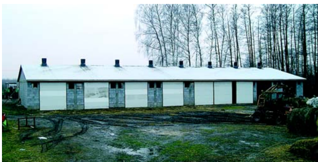
Widok ogólny na budynek tuczarni od strony wrot
