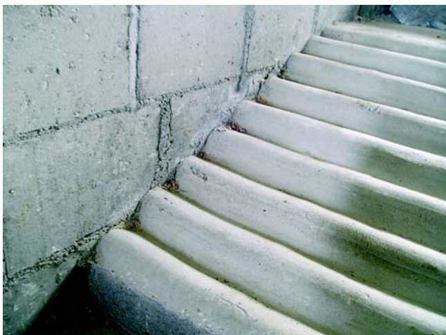
Pomysłowy sposób wykonania schodków w części żywieniowej. Stopnie wylane przy użyciu formy z dachowej płyty falistej
