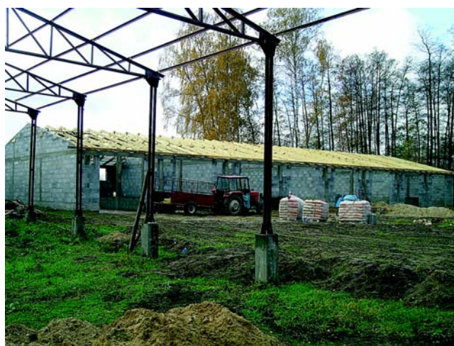
Widok ogólny budynku w trakcie budowy - widok od strony wrot
