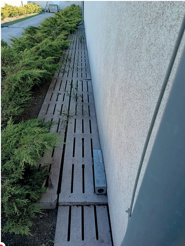
3. Przykład dobrze umieszczonej stacji deratyzacyjnej w linii budynków. Dodatkowym zabezpieczeniem jest utwardzenie terenu zużytymi rusztami za linią nasadzeń
