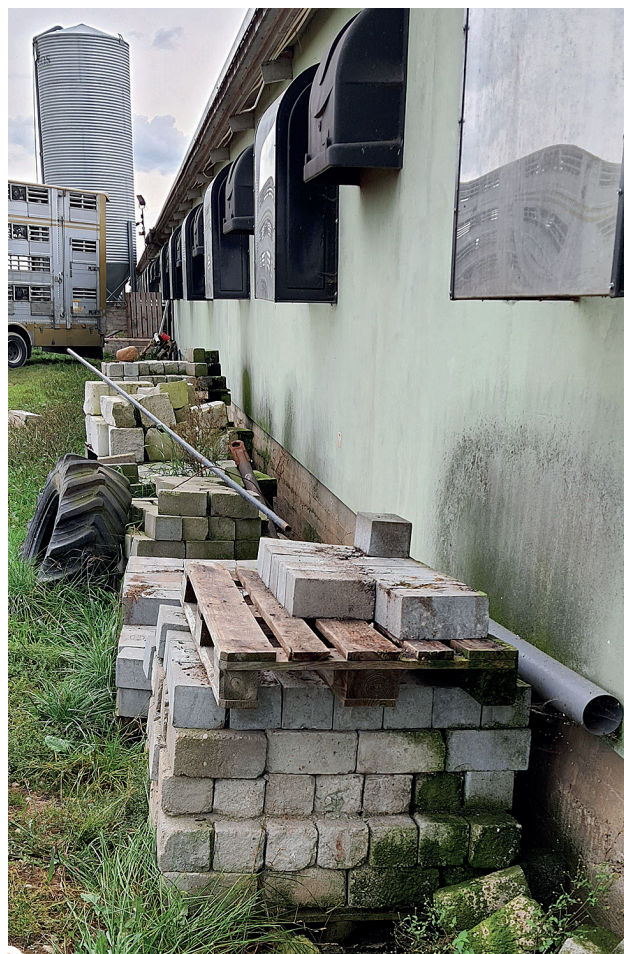
9. Często obserwowany obrazek – składowisko materiałów i sprzętów wzdłuż ścian budynków inwentarskich
