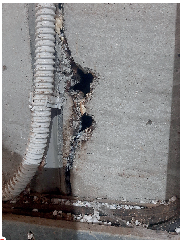
1. Dziury wykryte podczas sprawdzania gryzonioszczelności obiektów
