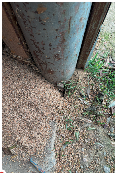
Fot. 3. Niezabezpieczony magazyn zbóż
